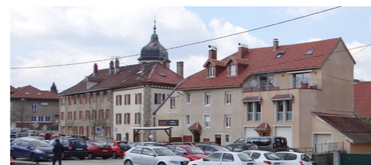
L'emplacement de la porte et de la tour de Morieux
