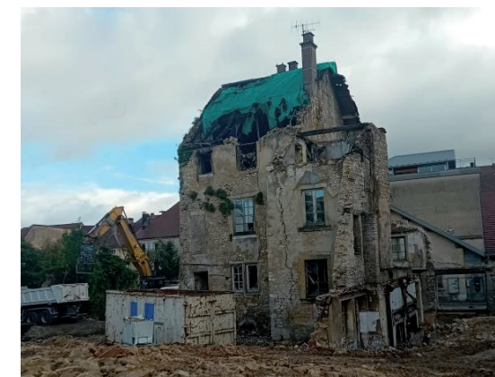
La démolition en cours 12.09.2025
